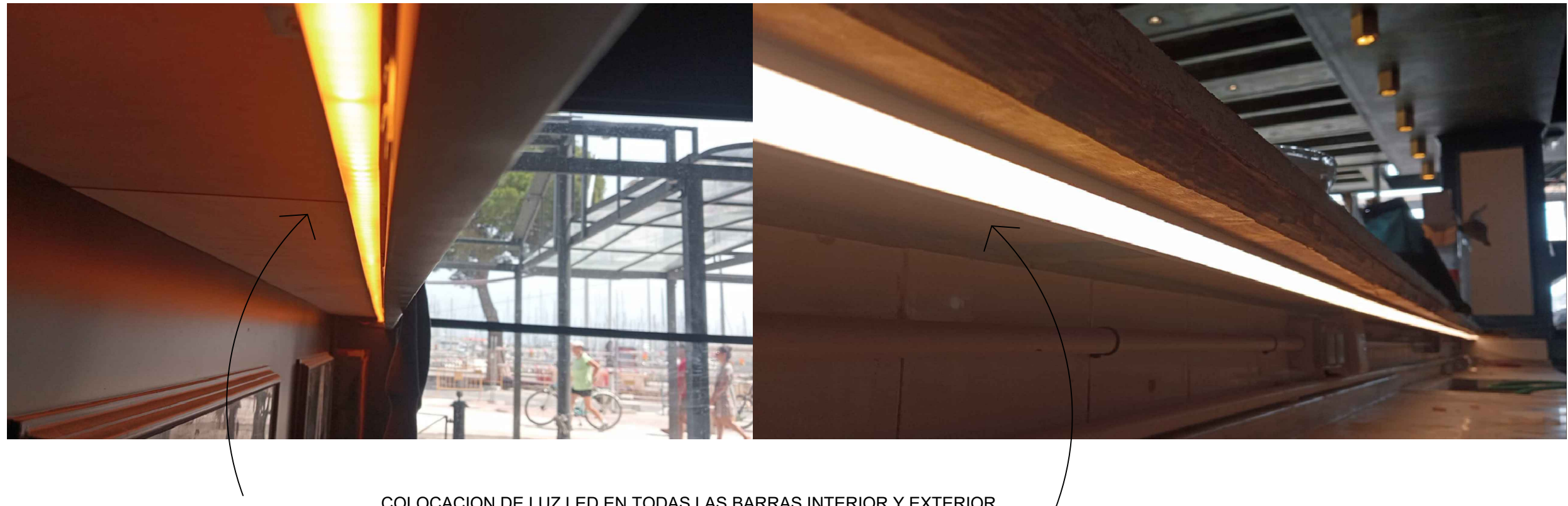
COLOCACION DE LUZ LED EN TODAS LAS BARRAS INTERIOR Y EXTERIOR
