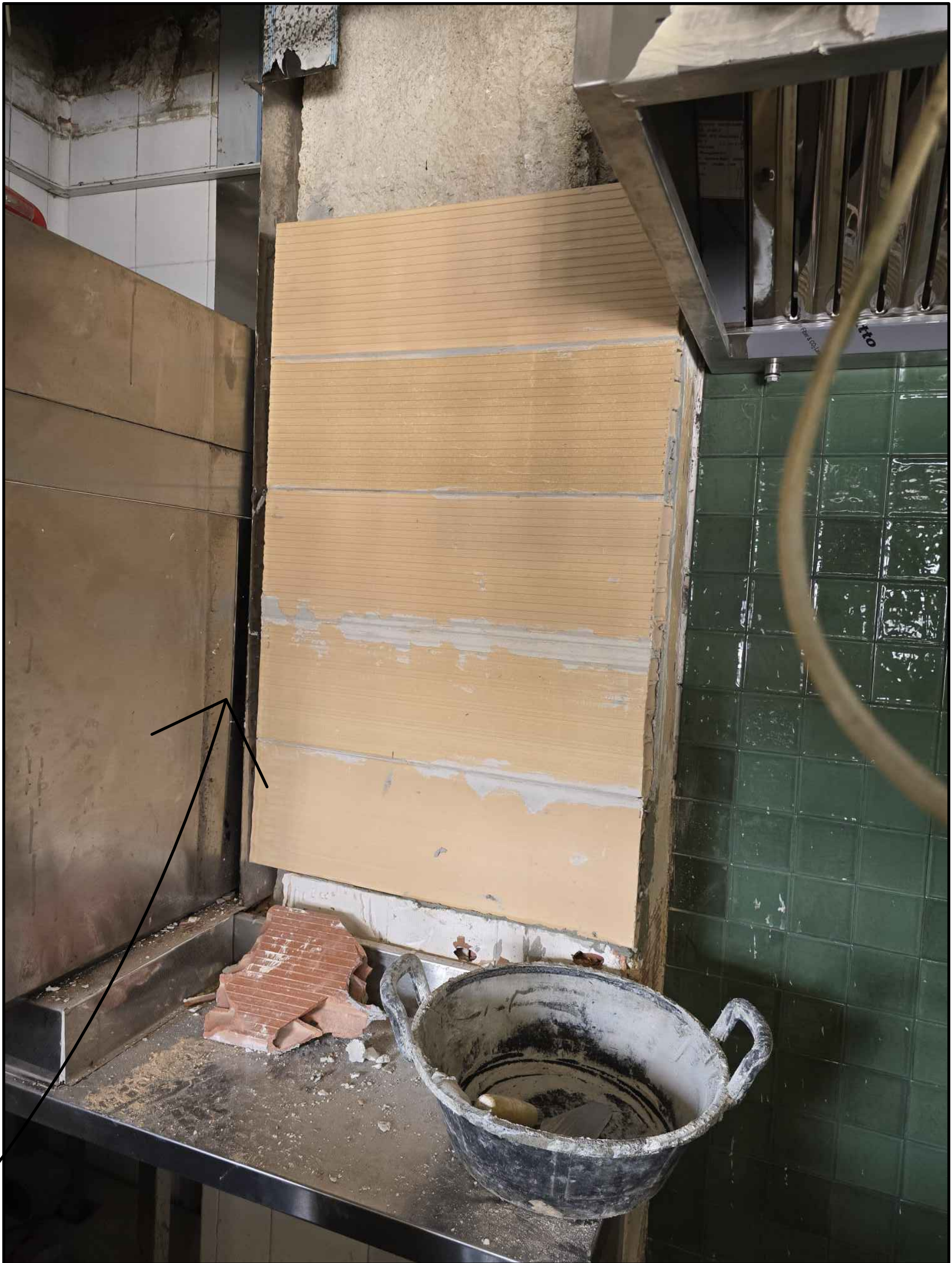
REPARACION PILAR Y POSTERIOR PREPARACION PARA ALICATAR
