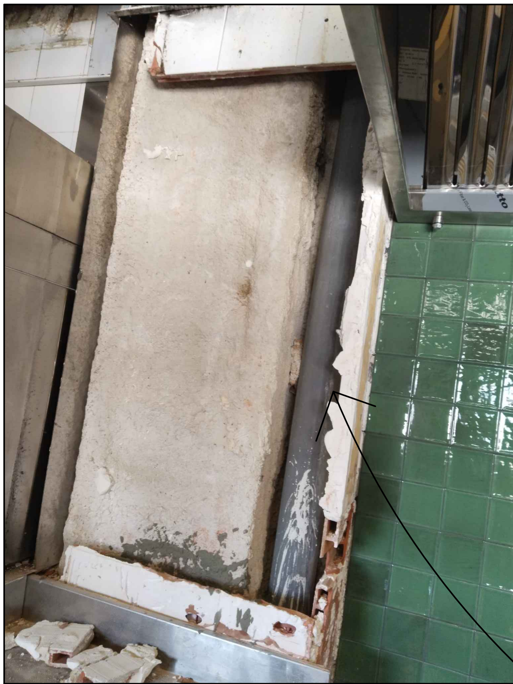
REPARACION PILAR Y POSTERIOR PREPARACION PARA ALICATAR
