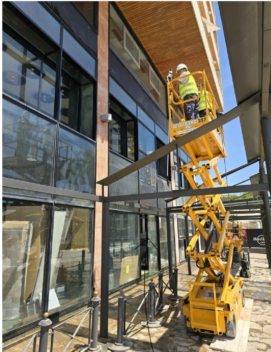
PLATAFORMA EN USO POR LIMPIEZA DE 11 A 14H
