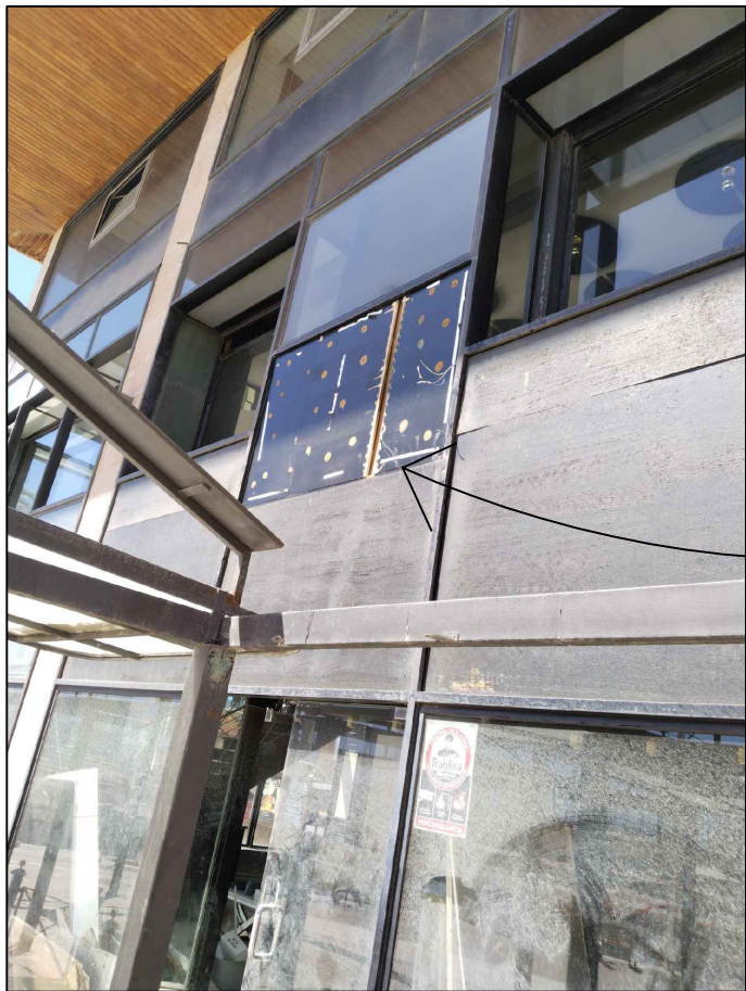
REGATAS INSTALACIONES COCINA PRINCIPAL.
