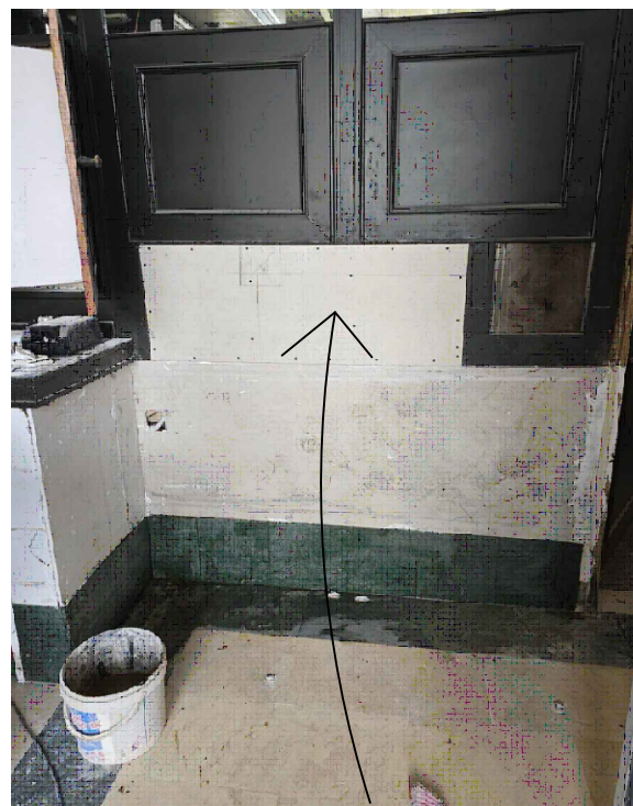
SE TAPA ACCESO ANTIGUA ZONA LAVADO CON PLADUR
