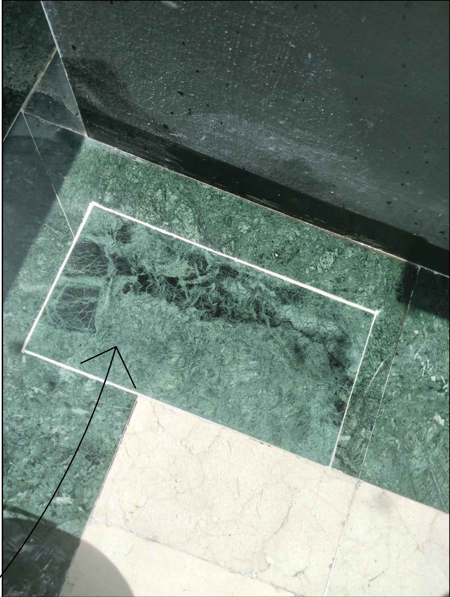
TAPADO HUECO FORJADO JUNTO ESCALERA
