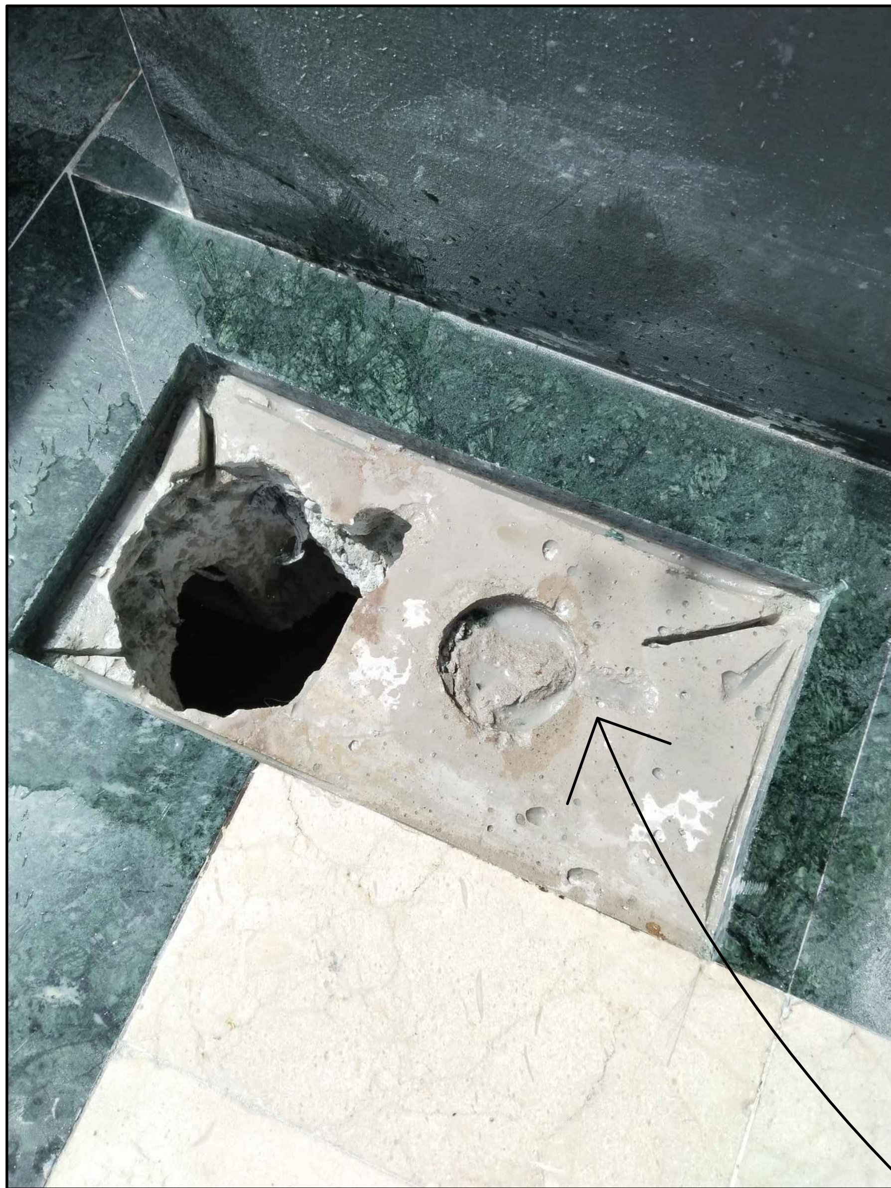
TAPADO HUECO FORJADO JUNTO ESCALERA
