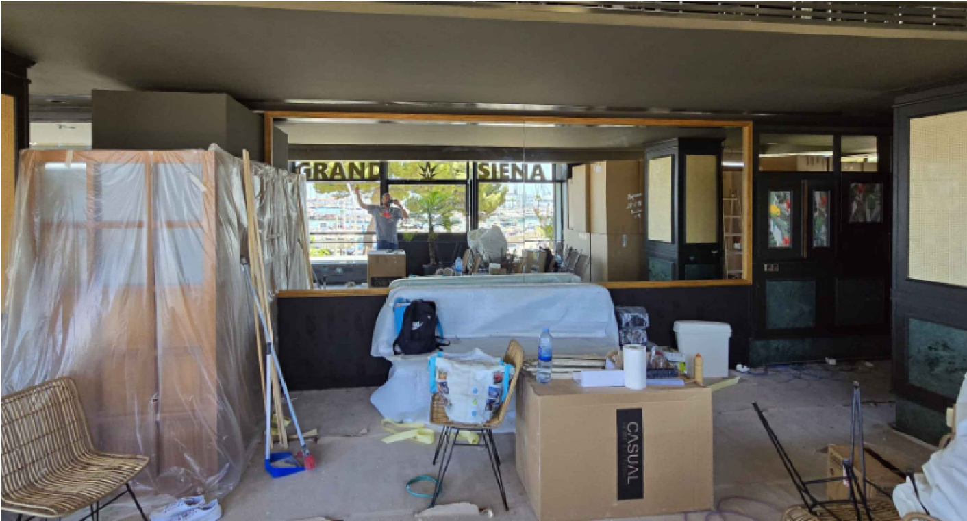
COLOCACION DE MARCOS EN ESPEJOS
