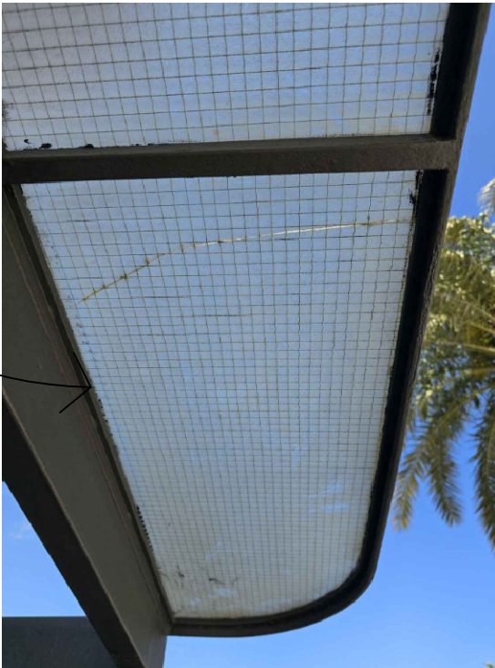
CRISTAL ARMADO ROTO
